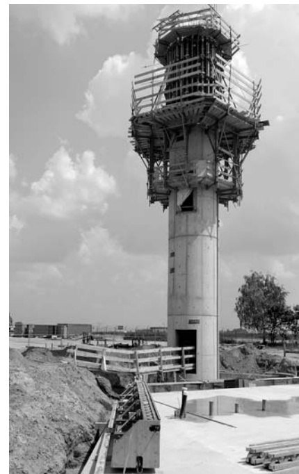
Der BBI-Infotower wird gebaut
